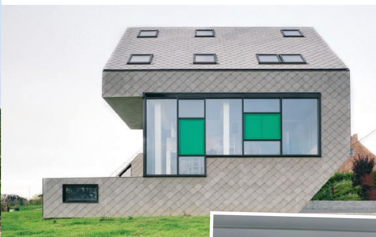
Belgia | Pasywny budynek jednorodzinny o charakterystycznej dla tego typu budowli zwartej konstrukcji. W obiekcie zastosowano okna dachowe FTT U8 Thermo o współczynniku U_w = 0,58 \text{ W}/(\text{m}^2\text{K})
