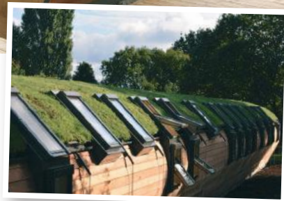
Wielka Brytania | Green Unit to ekologiczne budynki modułarne o podwyższonej energooszczędności. W modułach zastosowano superenergooszczędne okna dachowe FAKRO FTP-V U5 o współczynniku przenikania ciepła U_w = 0,97 \text{ W}/(\text{m}^2\text{K})
