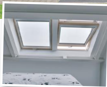
Belgia | Pasywny budynek jednorodzinny o charakterystycznej dla tego typu budowli zwartej konstrukcji. W obiekcie zastosowano okna dachowe FTT U8 Thermo o współczynniku U_w = 0,58 \text{ W}/(\text{m}^2\text{K})
