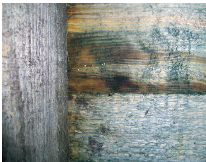
Deski pod papą (widok od wewnątrz). Wilgoć zawsze pojawia się wzdłuż styków desek. Widać małe grzyby
