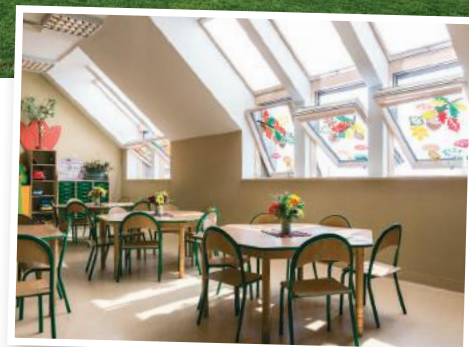
Polska | Przedszkole o standardzie pasywnym w Podegrodziu. Budynek wyposażony został w kolektory słoneczne oraz pompę ciepła. W obiekcie zastosowano okna dachowe FTT U8 Thermo o współczynniku U_w = 0,58 \text{ W}/(\text{m}^2\text{K})
