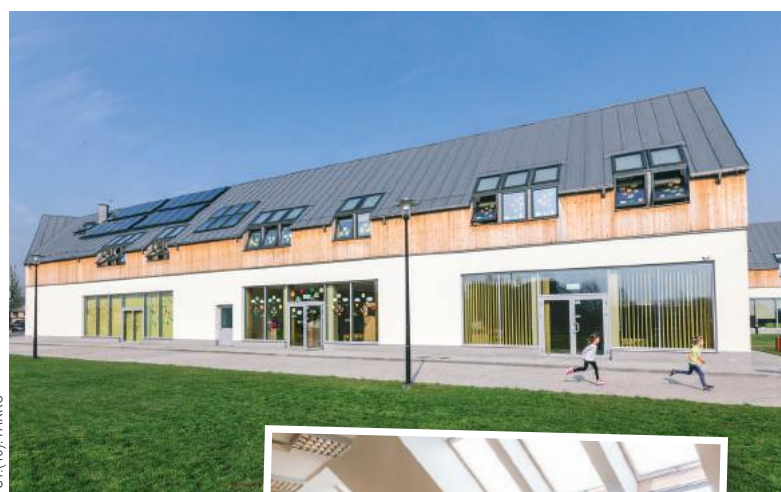
Polska | Przedszkole o standardzie pasywnym w Podegrodziu. Budynek wyposażony został w kolektory słoneczne oraz pompę ciepła. W obiekcie zastosowano okna dachowe FTT U8 Thermo o współczynniku U_w = 0,58 \text{ W}/(\text{m}^2\text{K})
