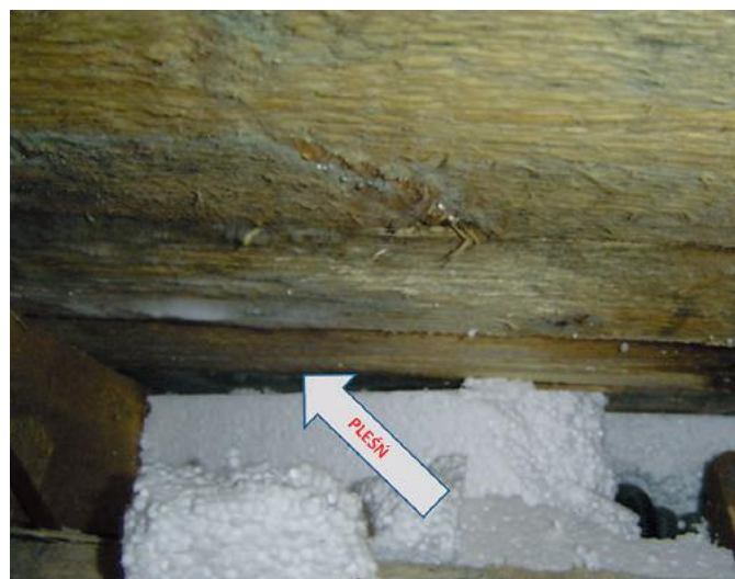
Papa na deskowaniu, a pod nią zawilgocenie. To jest połączenie muru z dachem w obszarze murłaty
