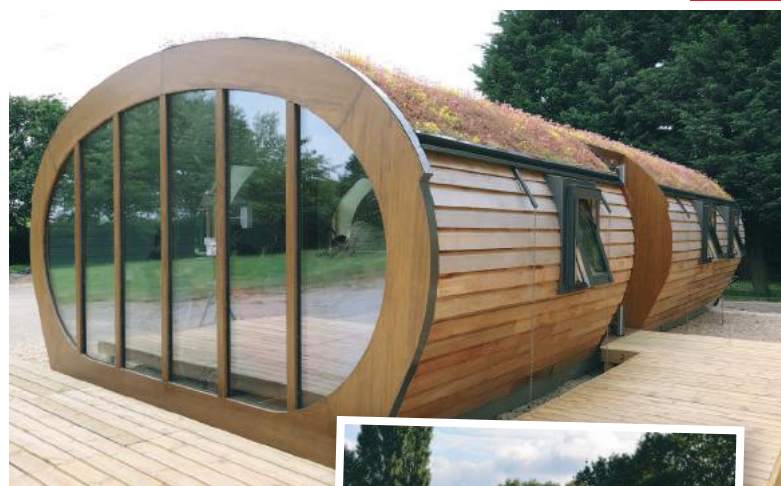
Wielka Brytania | Green Unit to ekologiczne budynki modułarne o podwyższonej energooszczędności. W modułach zastosowano superenergooszczędne okna dachowe FAKRO FTP-V U5 o współczynniku przenikania ciepła U_w = 0,97 \text{ W}/(\text{m}^2\text{K})
