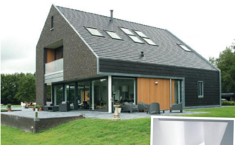
Holandia | Podczas projektowania budynków o podwyższonej energooszczędności ważną jest również jego orientacja względem stron świata. Superenergooszczędne okna dachowe użyte podczas realizacji to FAKRO FTP-V U5 o współczynniku przenikania ciepła U_w = 0,97 \text{ W}/(\text{m}^2\text{K})
