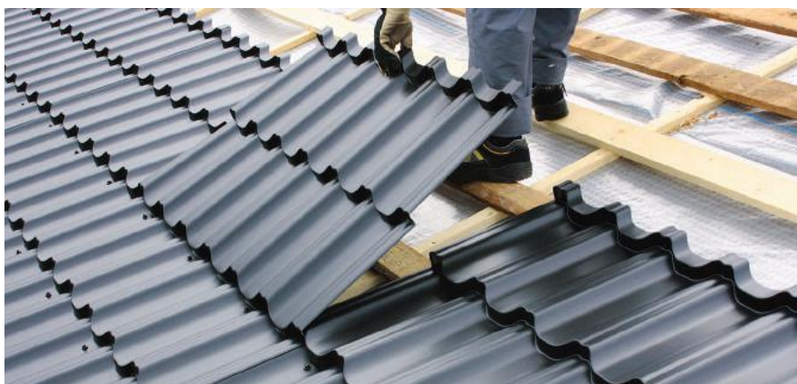
Montaż blachodachówki modułowej
