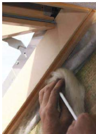
KROK 3. Montaż okna w połaci dachu. Układanie kołnierza paroprzepuszczalnego i izolacji termicznej
