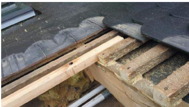
KROK 1. Wymierzenie i przygotowanie otworu na okno dachowe
