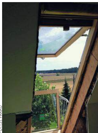
KROK 4. Sprawdzenie funkcjonalności okna
