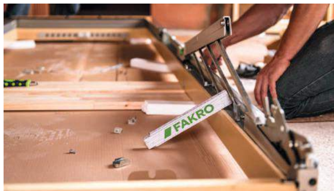
KROK 2. Przygotowanie okna do osadzenia w połaci
