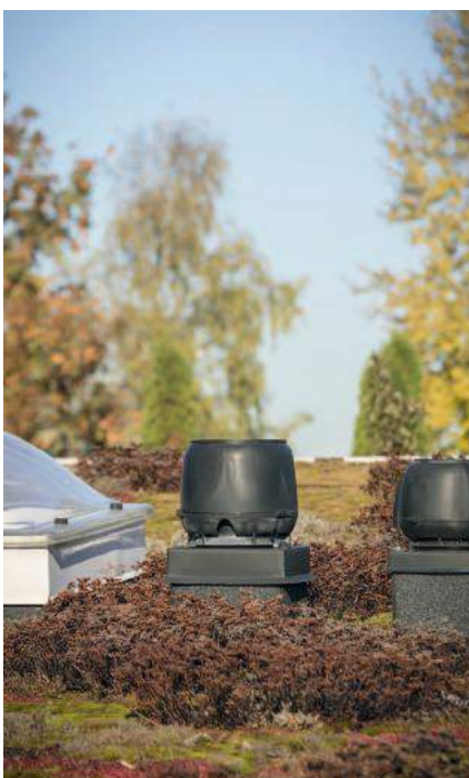
Wentylatory na dachu płaskim
