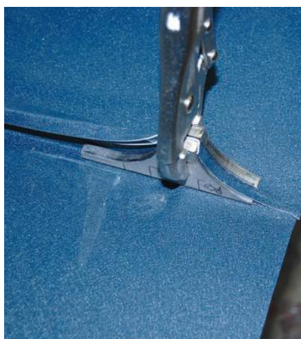
KROK 5. Zagięcie blachy na prasce okapu
