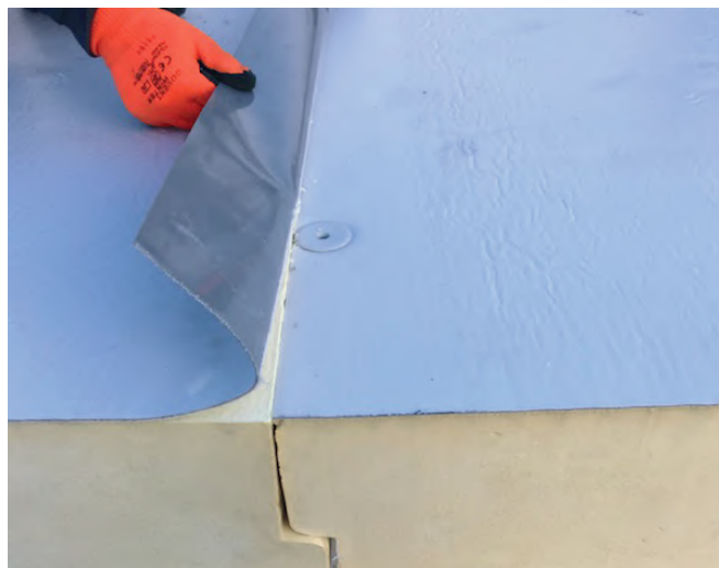
ThermaMembrane – umiejscowienie łącznika
