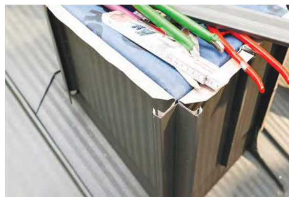
Obróbki elewacji komina z narożnikami łączonymi na rąbek kątowny. Elementami mocującymi są haftki i listwy wczepowe
