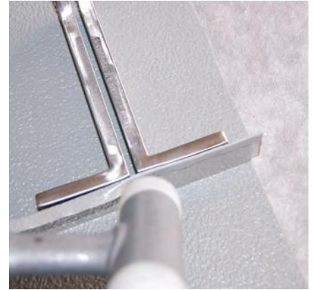
KROK 3. Dogięcie blachy. Wykonanie pojedynczego rąbka stojącego
