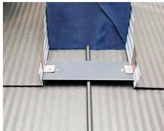
Dolna obróbka komina mocowana za pomocą haftek do listwy wczepowej
