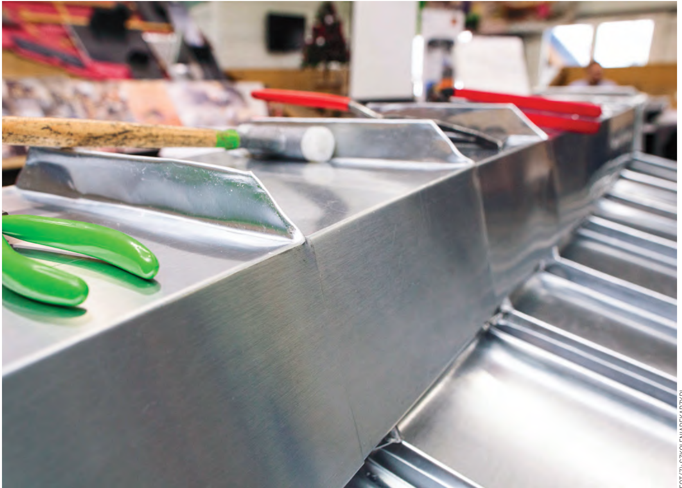
Atyka z formatek zamocowania w technologii rąbka stojącego
