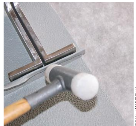
KROK 6. Dogięcie blach. Wykonanie podwójnego rąbka stojącego
