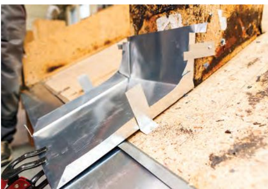
Bezwkretowe mocowanie obróbki przedniej komina
