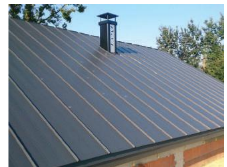
Dojście do komina powinno być wykonane tak, by przy jego obsłudze nie uszkodzić pokrycia
