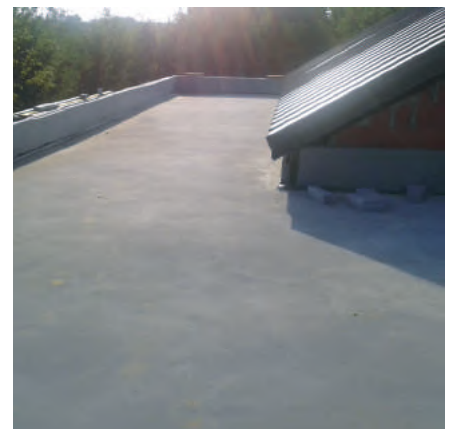
Stropodach powinien mieć ukształtowane spadki w kierunku lejów odpływowych
