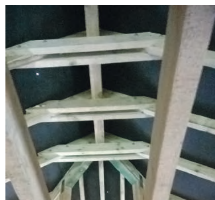
Jeśli membrana dachowa uległa uszkodzeniu lub perforacji, powinna być zaklejona
