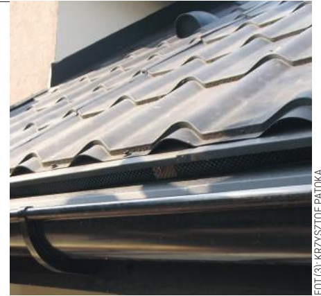
Fot. 4. Dach z dużą lukarną o problemie podobnym do zilustrowanego na rys. 1. Zlewnia kosza lukarny jest zawieszona na łątach i Stylvent znakomicie uzupełnił powierzchnię wlotu dla powietrza wentylującego połacie lukarny i tę widoczną podstawową
