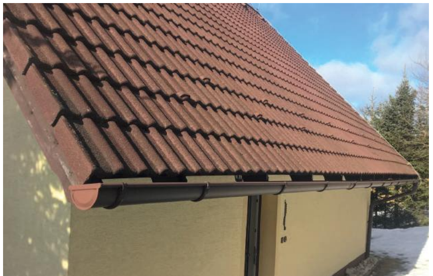
Brak obróbki blacharskiej wzdłuż rynien powoduje zimą rozpieranie rynny przy krawędzi dachu przez zamarzającą wodę z roztopionego śniegu
