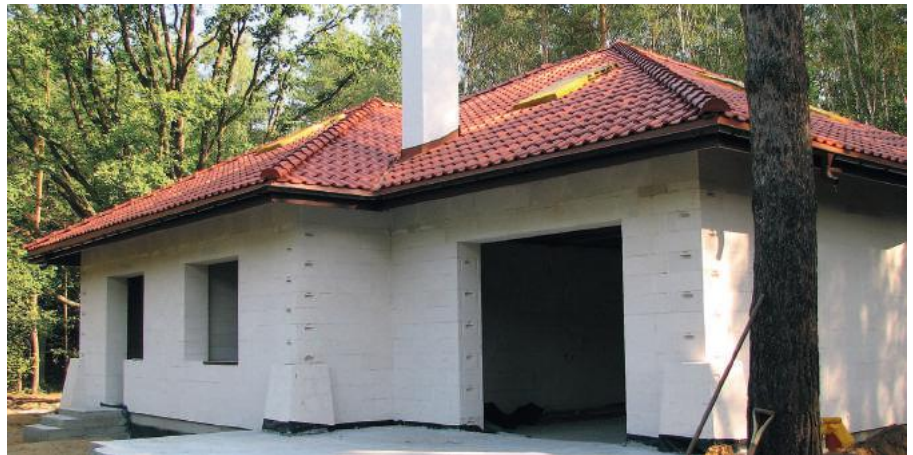
Zabezpieczenia przeciwnięgowe są potrzebne w obszarze użytkowania budynku
