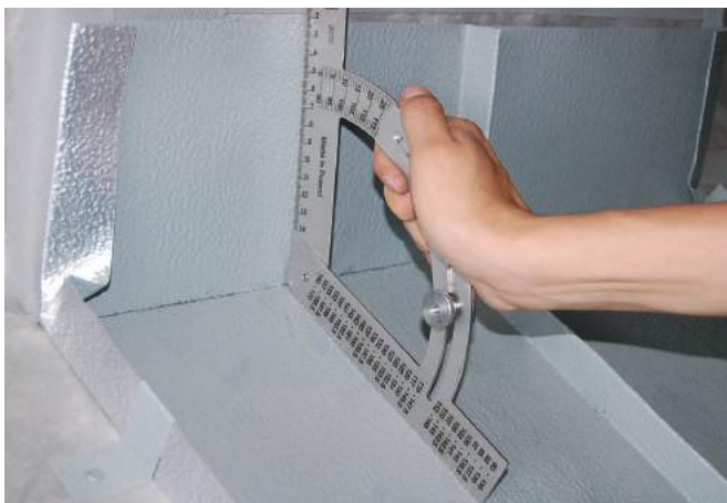
KROK 3. Przyłożenie kątownika, odczyt kąta między kominem a dachem
