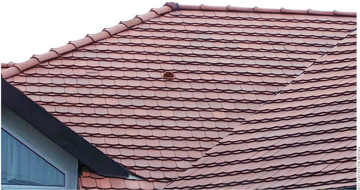
Fot. 1. Typowe zastosowanie dachówki wentylacyjnej „dla ozdoby”. Szczególnie na dachu skomplikowanych kształtach, które utrudniają wykonanie wystarczających wlotów do szczeliny wentylacyjnej w okapie. Zastosowanie jednej dachówki bardzo rzadko ma sens
