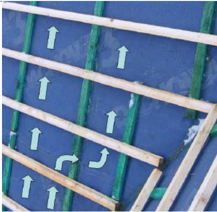
Fot. 2. Dach w budowie. Zlewnie w koszach będą zawieszane na łątach. Dzięki temu, powietrze wentylujące przepływające wzdłuż kontrłat, może przeskoczyć nad nimi do sąsiednich stref koszowych, do których nie ma wlotu w okapie
