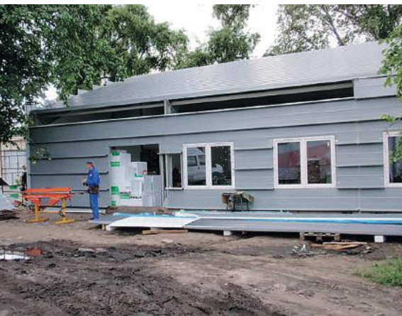
Budowa ośrodka kształcenia w Pruszkowie
