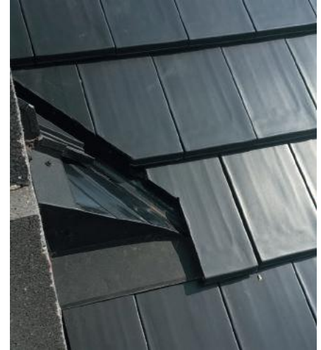
Cięte krawędzie dachówek powinny być zabezpieczone przed zawilgoceniem
