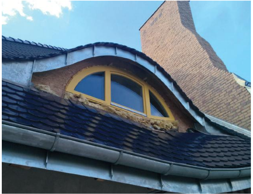
Niewłaściwie przygotowane olatowanie może powodować żeżenie się dachówki
