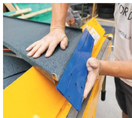
Przygotowanie panelu do zaczepienia o kosz
