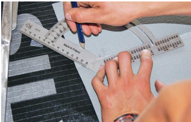
KROK 1. Trasowanie, wyznaczenie linii gięcia blachy
