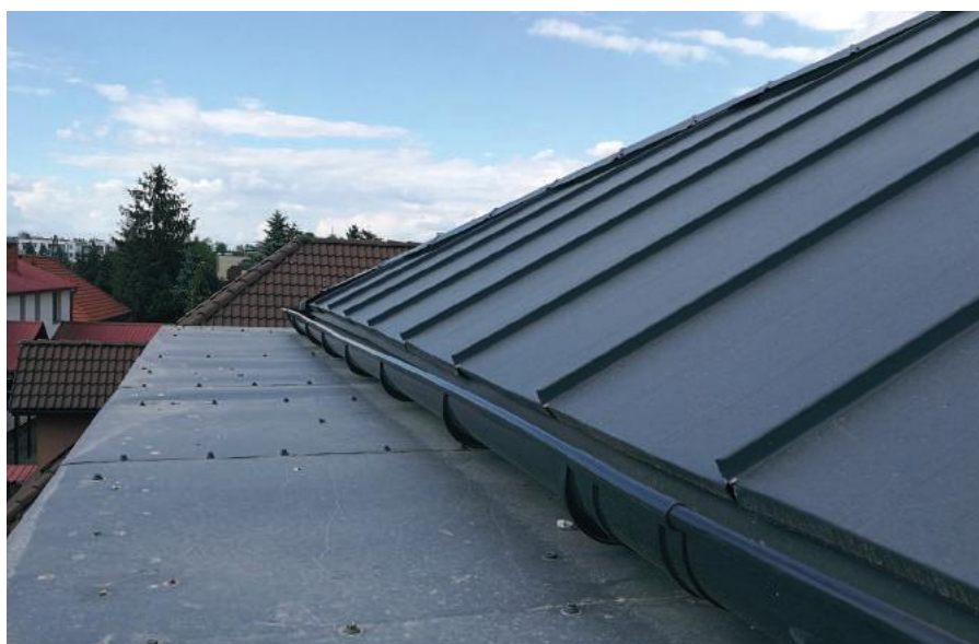
Za małe spadki okapu, odkształcone arkusze obróbki powodują nieszczelności
