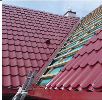
Fot. 3. Dach opisany w tekście z wywietrznikiem Stylvent, uzupełniającym ilość powietrza potrzebnego do wentylowania pokrycia dachu. Dach ma duży wykuszczone ograniczający powierzchnię wlotów w okapie
