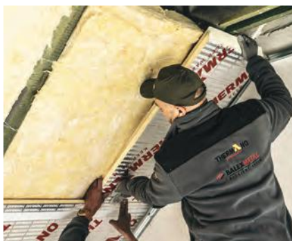
3 Mocowanie płyt Thermano pod krokiewmi
