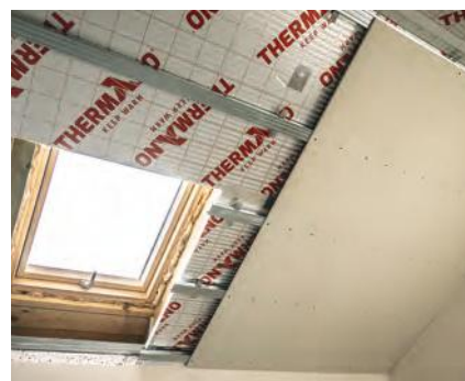
7 Mocowanie płyt GK za pomocą wkrętów
