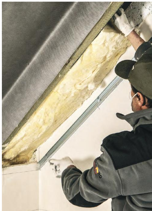
1 Montaż wełny między krokiewiami
