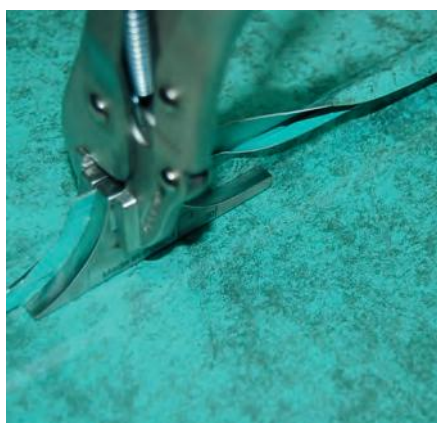
KROK 8. Przygotowanie do łączenia blach z użyciem praski okapu
