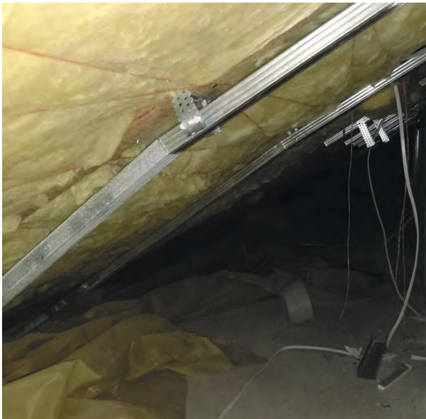
Ocieplenie połaci dachowej nie zawsze wykonują dekarze. Na tym etapie budowy popełniane bywają błędy, później niesprawiedliwie przypisywane dekarzowi
