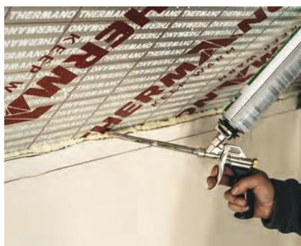
5 Wypełnienie szczelin pianką niskoprężną
