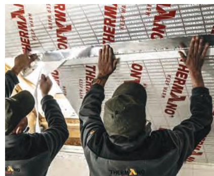
4 Zaklejenie taśmą aluminiową styków między płytami PIR
