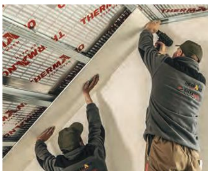
6 Listwy systemowe montowane poprzez Thermano do krokwi
