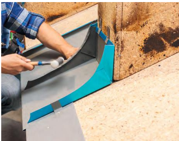
Mocowanie haftrami i falcowanie na pierwszy rąbek
