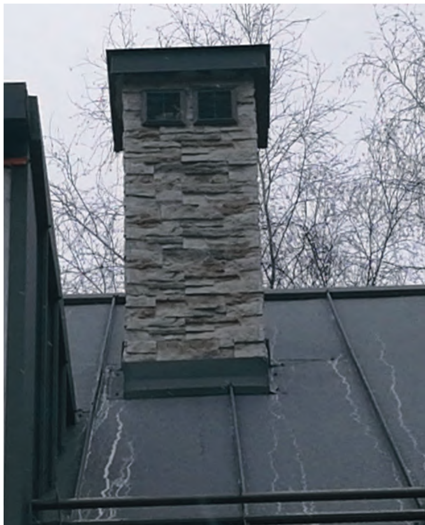
Nieszczelna obróbka wokół komina spowodowała przecieki, gdyż została nieprawidłowo wykonana
