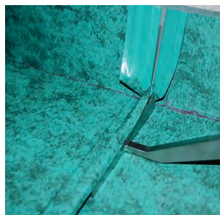
KROK 7. Odtworzenie rąbka górnego kowadełkiem MK_15
