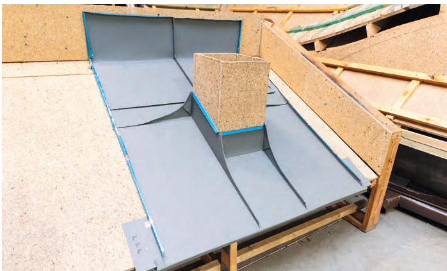
Gotowa obróbka. Falc przeciwwodny, widoczna fałda z falcem łączącym dwa elementy
