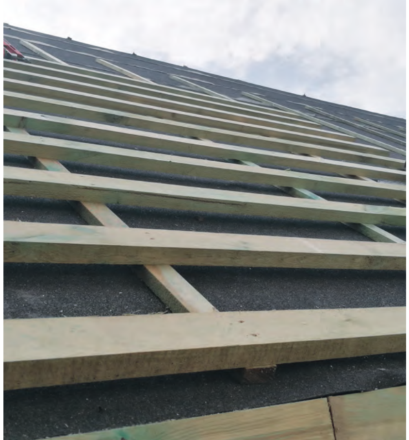
Łacenie przygotowują sobie dekarze. Zrobią to precyzyjnie, gdyż wiedzą, że sami będą układać pokrycie dachu
