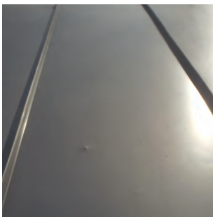
Fot. 1. Zjawisko wychodzenia śrub i gwoździ ponad powierzchnię podkładów jest związane z ruchami więźby dachowej, wywołanymi wysychaniem drewna, ciężarem całego dachu i obciążeniami pochodzącymi od wiatru
