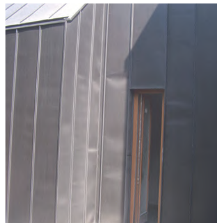
Fot. 6. W tym budynku, na tej ścianie architekt zaprojektował długie szary. Efektem są pofalowania blachy, ponieważ jest ona ułożona na macie strukturalnej i żabki mocujące pod wpływem ruchów termicznych i ciężaru przechylają się i kleszczą mocowanie
