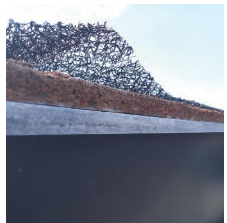
Fot. 3. Płyty wiórowe często puchną pod wpływem wilgoci przenoszonej przez powietrze i mury. Najbardziej na krawędziach, z których często wyplukiwane są żywice. Dlatego styki płyt wystają ponad płaszczyznę poszycia. Z tego powodu zaleca się układanie na nich mat z membranami
