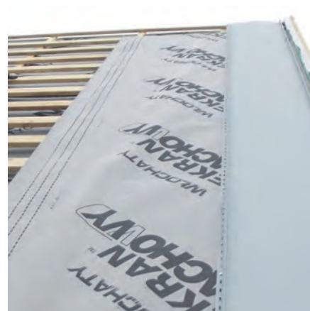
Fot. 10. Inny dach z rozwiązaniem jak na fot.9. Widać kalenicę, gdzie pozostawiono wylot dla powietrza wentylującego nad ostatnią łątą (deską 11 cm). Warstwa poślizgowa ze specjalnej MWK jest zamocowana do krawędzi (od góry) ostatnich desek. Okap taki sam jak na fot.9
