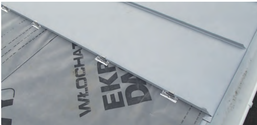
Fot. 7. Dach o niskim nachyleniu (10°) pokryty blachą aluminiową o grubości 0,8 mm, łączoną na podwójny rąbek stojący z podkładem w postaci specjalnej grubej MWK, pełniącej tutaj funkcję warstwy poślizgowo-rozdzielającej. Pod spodem jest płyta OSB. Widać dwa rodzaje żabek
