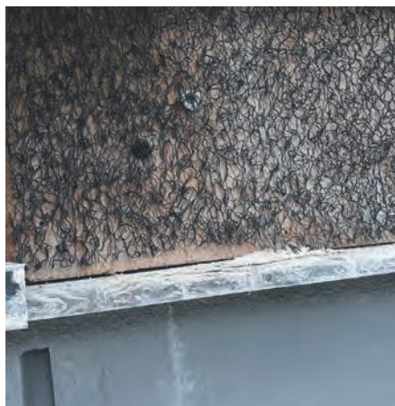
Fot. 5. Ta sama elewacja jak na fot. 4 z odśloniętą warstwą podkładową. Z płyt wiórowych skropliny wypływają żywice łączące wióry. Widać ich osad na kapinosach. Do osłony płyt zamiast opłotu powinno się użyć wysokoparoprzepuszczalnych membran o wysokiej gramaturze
