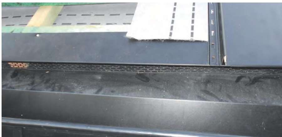
Fot. 9. Najlepszy układ warstw pokrycia dla rąbkopodobnych paneli zatrząskowych. Pod blachą jest specjalna MWK jako warstwa poślizgowa, a pod spodem – gęsto bite łąty i kontrłaty, pod którymi jest druga warstwa MWK. Bardzo prosto i skutecznie zrobiony wlot wentylacji w okapie
