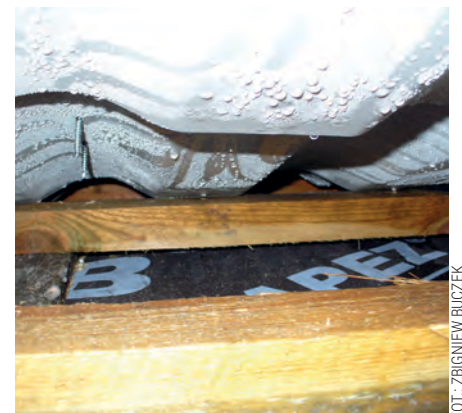
Fot. 3. Niska kontrłata i dodatkowo uszczelka pod gąsiorem powoduje brak przepływu powietrza, czego wynikiem jest gromadzenie się dużej ilości skroplin. Stała ich obecność w dwuletnim dachu przyczyniła się do powstania pleśni na listwach olatowania
