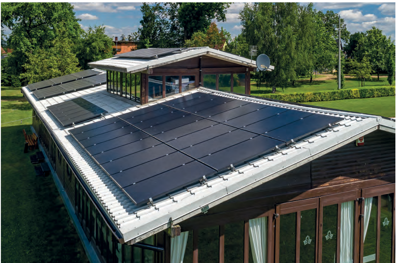
FOT.(3): BRUK-BET SOLAR
