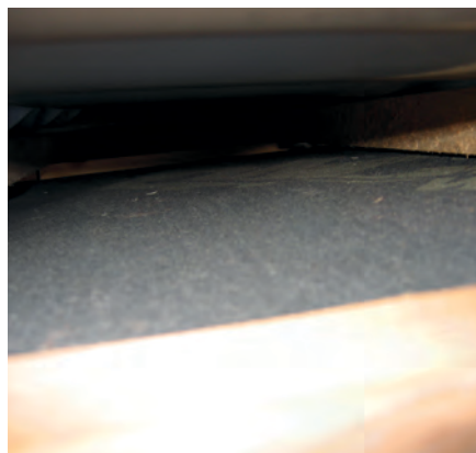
Fot. 2. Dach z bardzo mocną MWK, a mimo to termoizolacja ją wybrzuszyła. Przy kontrłatach o wysokości 2,5 cm odległość między MWK a łątami (przestrzeń wentylacyjna) ma wysokość 1-1,5 cm. Dach bez pleśni, ale ze skropliną pod MWK
