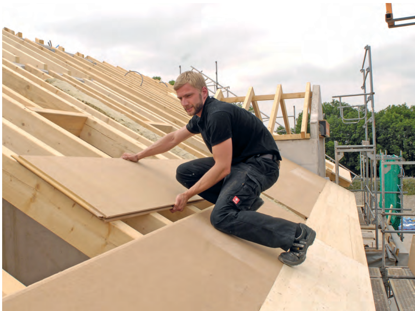
Montaż płyt STEICOuniversal bezpośrednio na krokwiach
