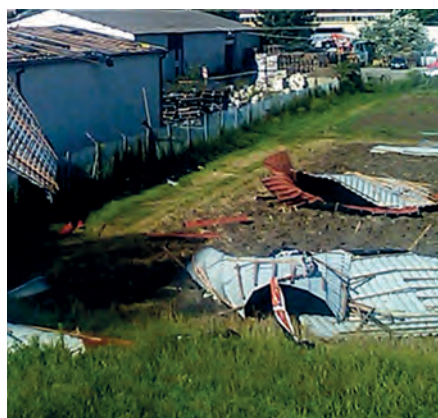
Fot. 6. Skutki takiego mocowania – za pośrednictwem słabych listewek (2,5 x 5 cm). Łączenie łąt do blachy farmerami jest skuteczne, ale ich połączenie z kontrłatami już nie. Widać jak dużo łąt zostało na blachach, a kontrłat prawie nie ma
