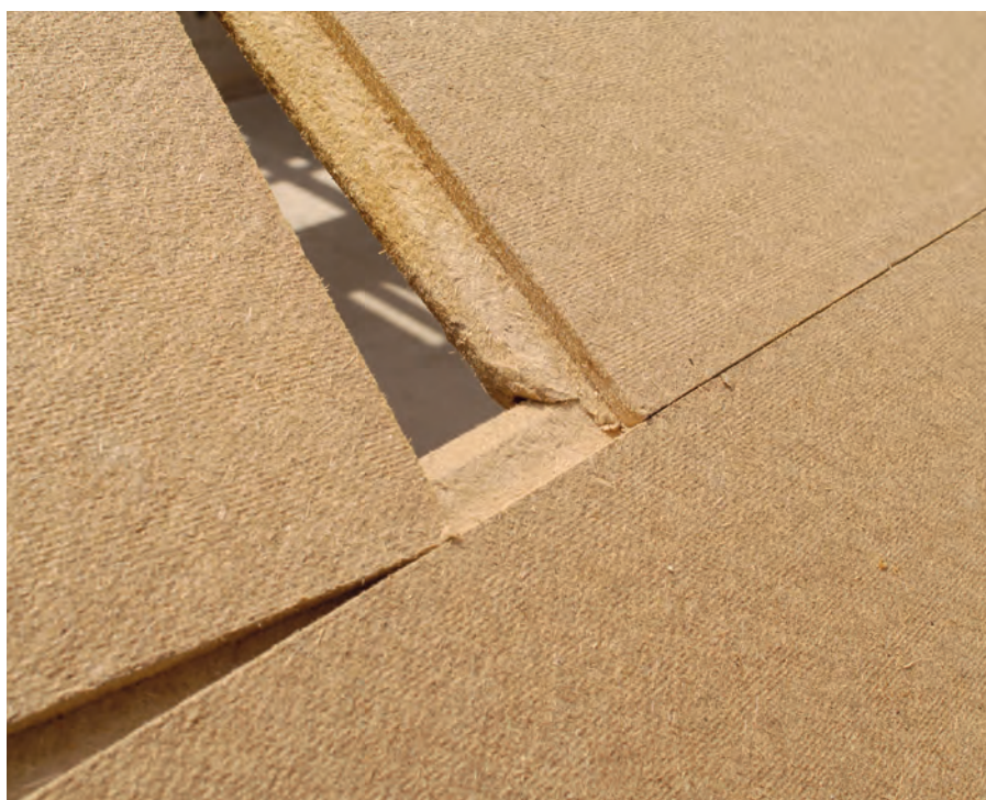
Proste połączenie płyt STEICOuniversal na systemowy profil pióro-wpust
