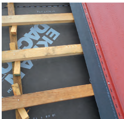
Fot. 7. Płaskość połączenia regulowana za pomocą klinów przybijanych do kontrłat. Do tego kontrłaty muszą mieć odpowiednią grubość i wytrzymałość. Pokrycie z paneli zatrząskowych rąbkopodobnych jest ułożone na warstwie poślizgowej ze specjalnej MWK. Jak widać, można sprzedać taką robotę
