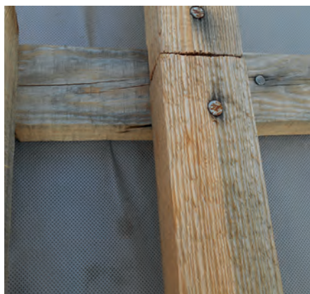
Fot. 5. Tak wygląda ołatowanie po 10 dniach od wykonania. Co będzie za rok? Pokryciem w tym (gotowym już) dachu jest blachodachówka. Gwoździe mocujące obie łąty rozszczepiły typową „kontrłatę” (2,5 x 5 cm). To nie jest mocowanie odporne na występujące siły ssące wiatru
