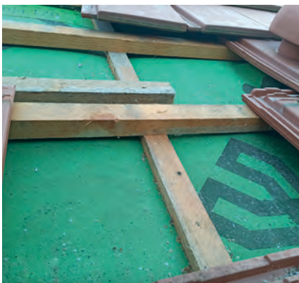
Fot. 1. Pleśń na łątach i MWK w nowym dachu. MWK wypchnięta przez termoizolację i kontrłaty o wysokości 2,5 cm stworzyły przestrzeń wentylacyjną o wysokości 1-1,5 cm na całym dachu. To za mało, aby popłynęło powietrze i osuszyło wilgoć napływającą przez MWK
