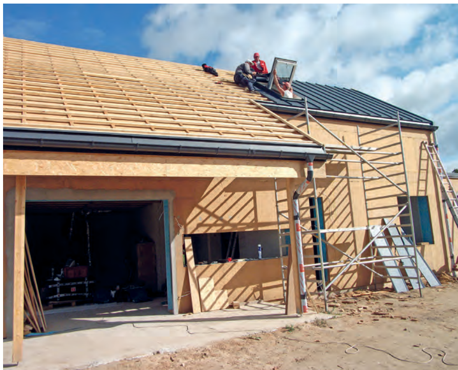
Dach pokryty płytami STEICOuniversal. Płyty przymocowane do krokwi poprzez kontrłaty
