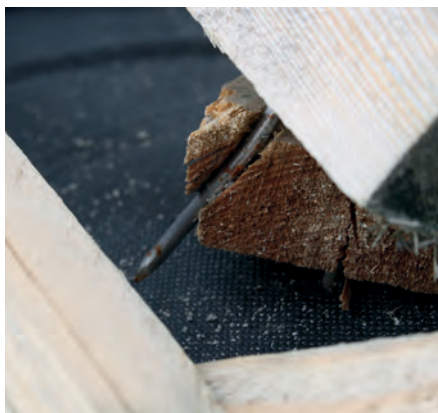
Fot. 4. Kontrłata 2,5 x 5 cm w koszu i to, co z niej zostało po przybiciu łąt. Takie listewki musiałyby być heblowane z klasyfikowanego drzewa liściastego, aby wytrzymały prawidłowe mocowanie. Często takie listwy z drewna iglastego pękają po wyschnięciu, czego nikt już nie widzi
