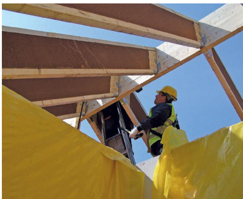
Połączenie krokwi STEICOjoist do kalenicy przy użyciu złączy ciesielskich
