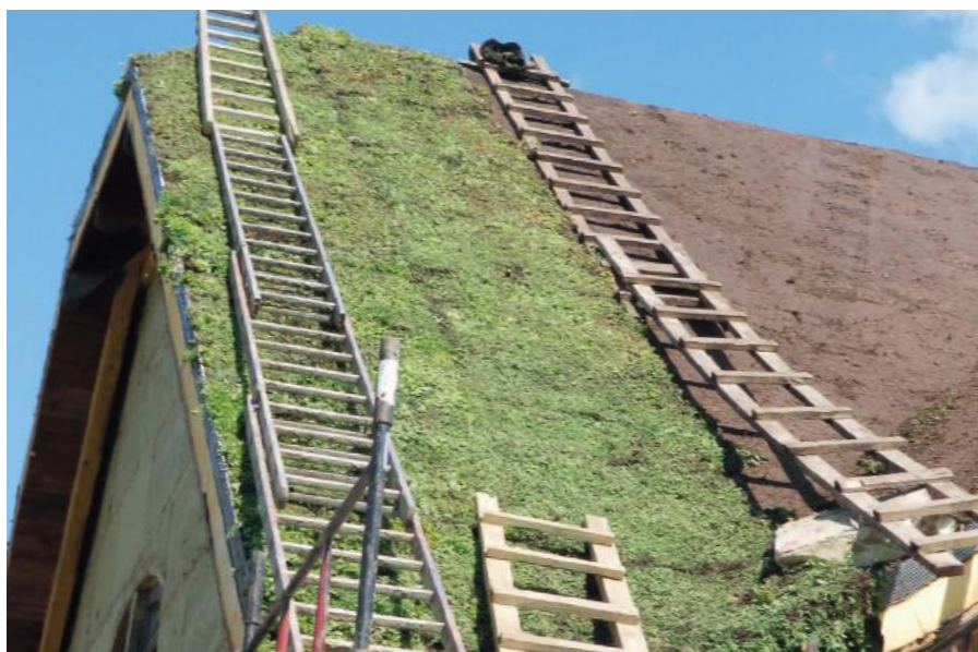
Fot. 3. Układanie mat rozchodnikowych na substracie
