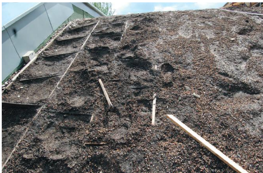
Fot. 5. Konsekwencje zastosowania elementów drewnianych jako konstrukcji zabezpieczającej przed osuwaniem
