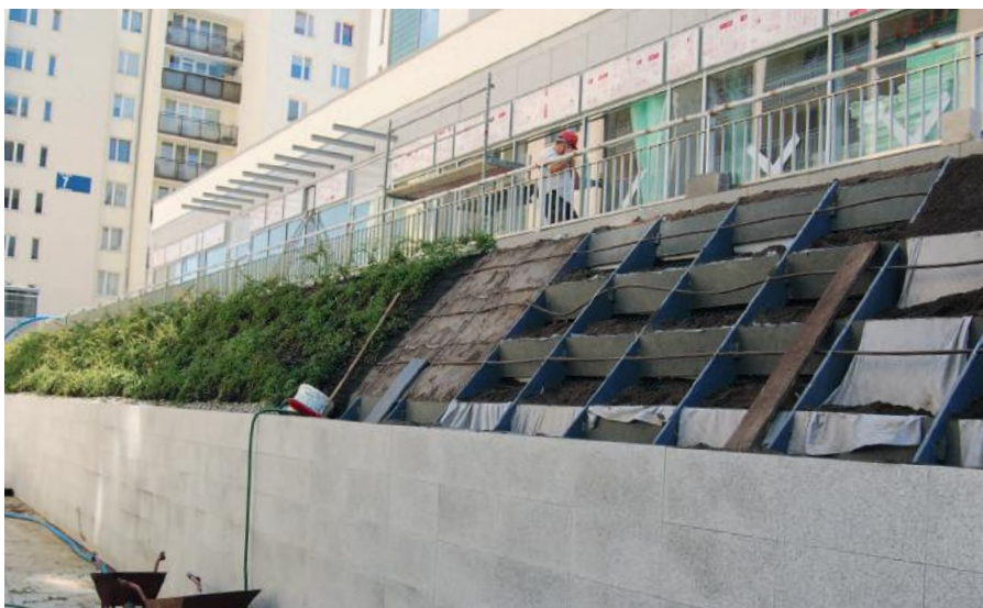
Fot. 2. Dach spadzisty intensywny w trakcie nasadzeń
