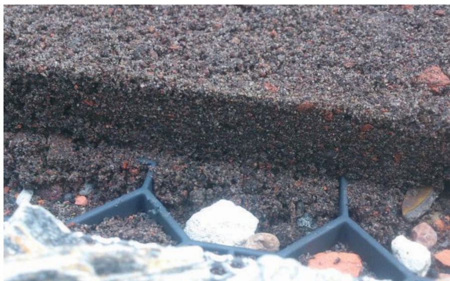
Fot. 4. Montaż kraterk drenażowych jako zabezpieczenia przed osuwaniem
