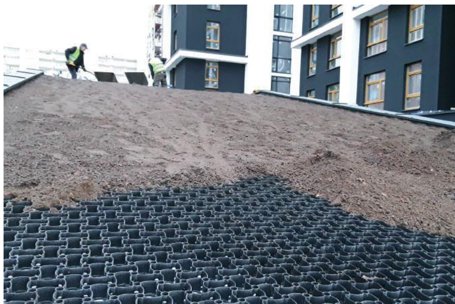
Fot. 5. Wypełnianie krtek drenażowych substratem
