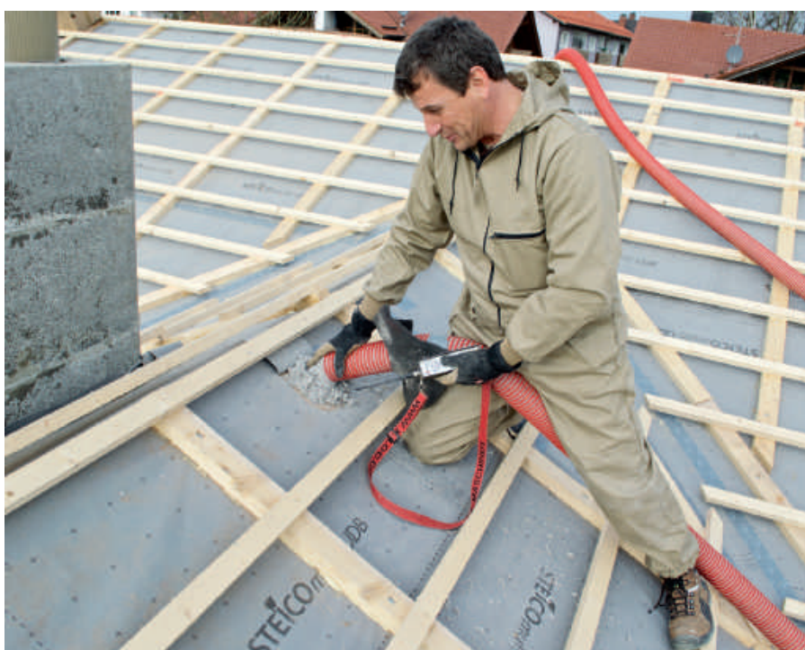
Aplikacja włókien drzewnych STEICOzell przy użyciu maszyny do wdmuchiwania X-Floc
