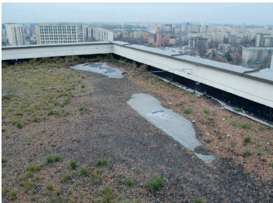
Fot. 6. Wywiewanie substratu przy attykach
