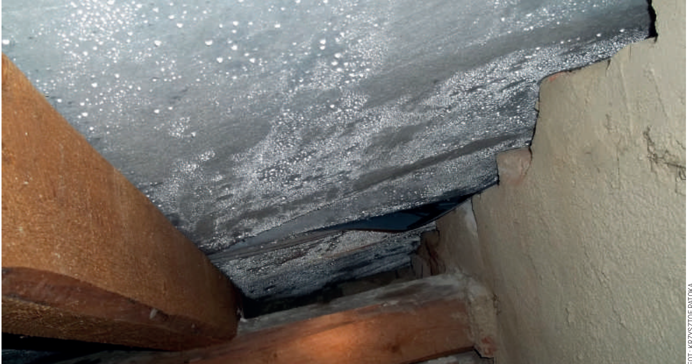
Resublimację – zamianę pary wodnej w lód – można zaobserwować zimą na cienkich materiałach budowlanych odgraniczających ciepłe i wilgotne ośrodki od zimnych (o temperaturze poniżej 0°C)
