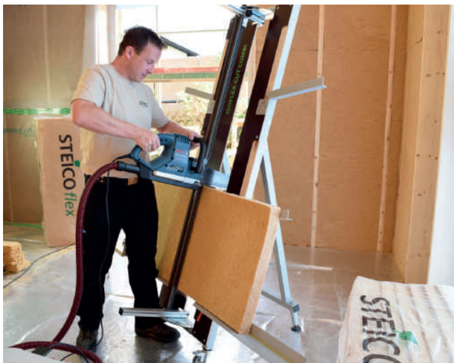
Obróbka mat STEICOflex 036 przy użyciu urządzenia STEICOisoflex cut combi
