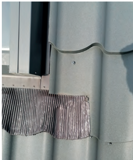
KROK 2. Po dokładnym przyjrzeniu się widać jednak, że plisowany fartuch podokienny jest nieprawidłowo wciśnięty w pokrycie, czego efektem było przeciekanie dachu
