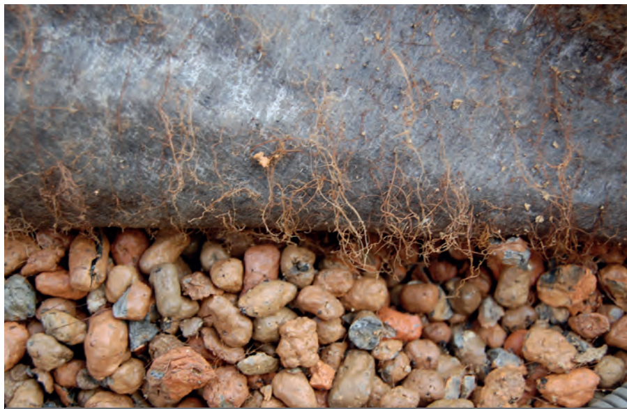
Drenaż magazynujący wodę z kruszywa (keramzyt)
