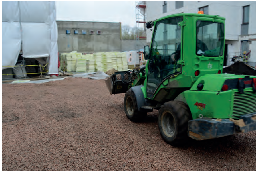
Lekka ładowarka na drenażu
