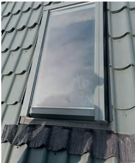
KROK 1. Okno połaciowe na pierwszy rzut oka jest obrobione poprawnie
