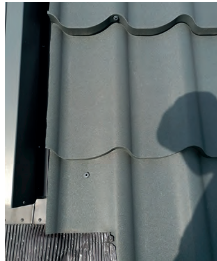
KROK 3. Żeby poprawić to połączenie, konieczne jest wykręcenie wkrętów z modułów po obu stronach okna po to, aby prawidłowo podciąć krawędzie arkuszy blachy
