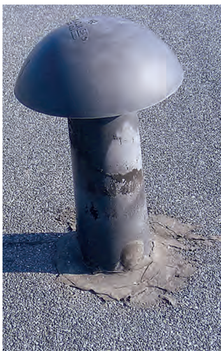
Fot.1. Typowy prosty kominek odpowietrzający montowany często na polskich dachach, ale jego zastosowania nie zawsze są uzasadnione, a czasami z fatalnymi skutkami dla dachów. Na dachach trzeba działać świadomie
