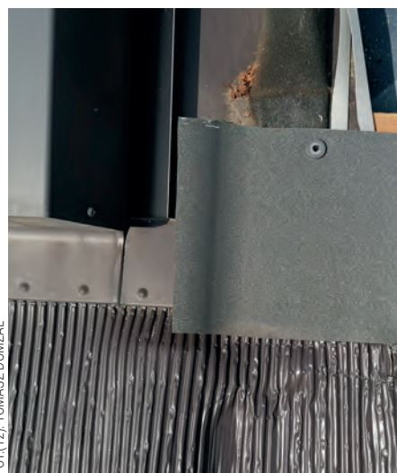
KROK 5. To, co zostało musimy również przyciąć, ale wzdłuż krawędzi obróbki bocznej okna
