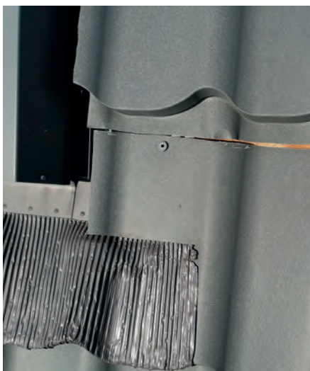
KROK 4. Następnie odcinamy około 5-10 cm nad dolną krawędzią kołnierza, cały moduł pokrycia dachowego
