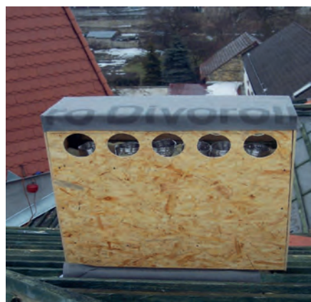
Fot. 2. Komin z obudową z płyt OSB
