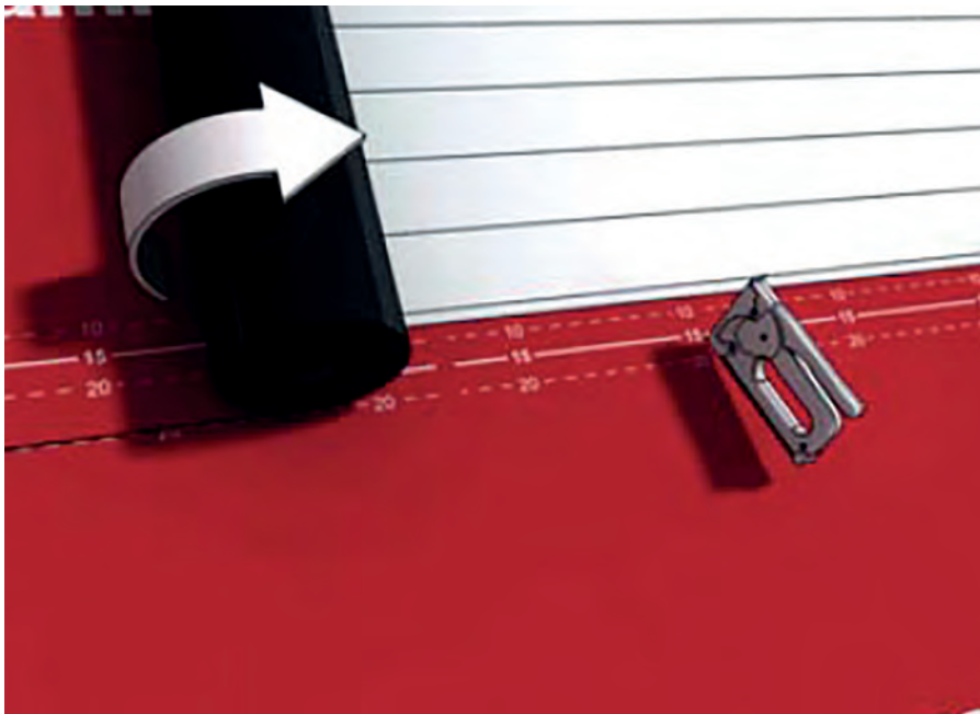
Rozwijanie i mocowanie membrany
