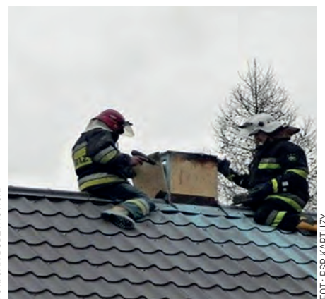
Fot. 3. Pożar komina z obudową z płyt OSB
