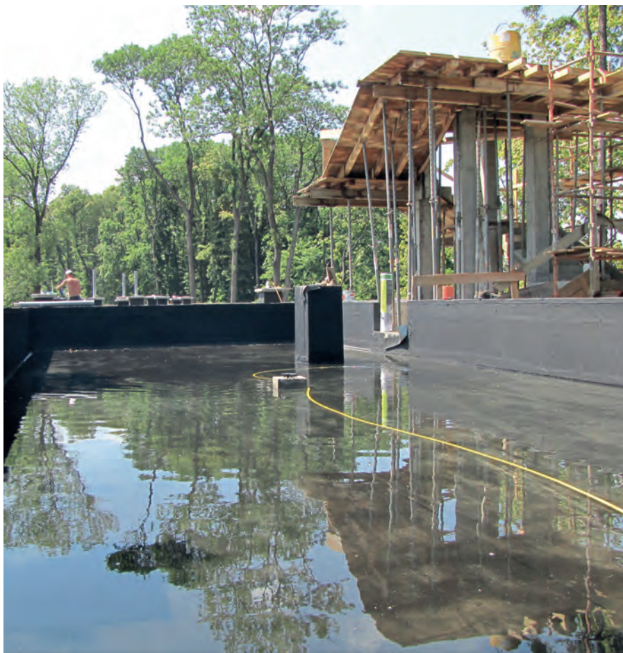
Próba szczelności wodnej przed ułożeniem pozostałych warstw dachu zielonego
