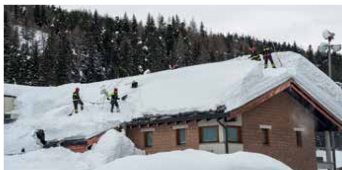
Odśnieżanie dachu z szelkami i liną bezpieczeństwa
