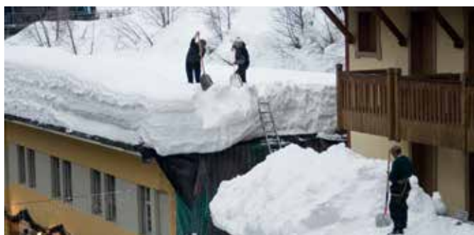
Odśnieżanie dachu bez szelek i liny!
