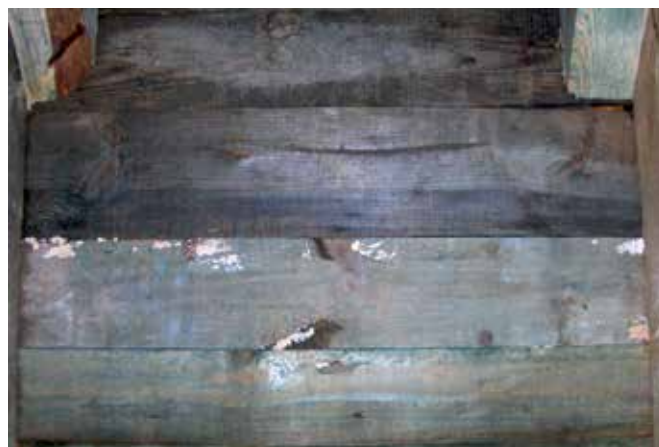
Zawilgocone, pokryte pleśnią deskowanie
