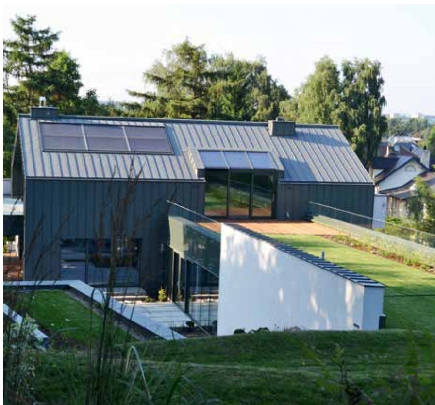
Dach zielony z wykorzystaniem antykorzennej hydroizolacji membraną EPDM Resitrix SKW
