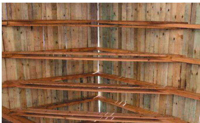
Pełne deskowanie pod dachówkę betonową
