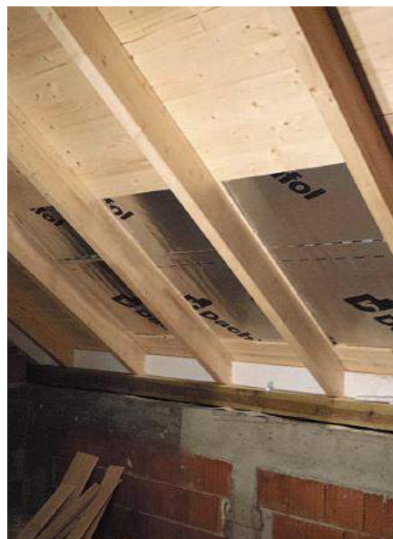
KROK 3. Wycięte wstępnie otwory w deskowaniu pod okna – zespolenie trzech okien w poziomie; widoczna izolacja paroszczelna (widok od strony pomieszczenia)
