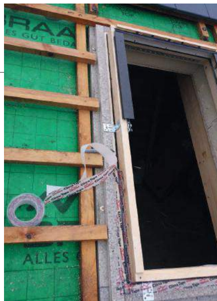
KROK 1. Elementy doszczelnienia – bok okna – docieplenie nakrokwiowe, łąty, ramka systemowa, taśma rozprężna i systemowa taśma klejąca, rama okna (widok od strony połaci)
