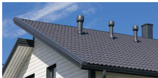
Właściwe usytuowanie elementów wentylacyjnych na dachu
