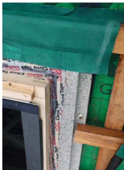
KROK 2. Elementy doszczelnienia – góra okna – docieplenie nakrokwiowe, łąty, ramka systemowa, systemowa taśma klejąca, rama okna (widok od strony połaci)
