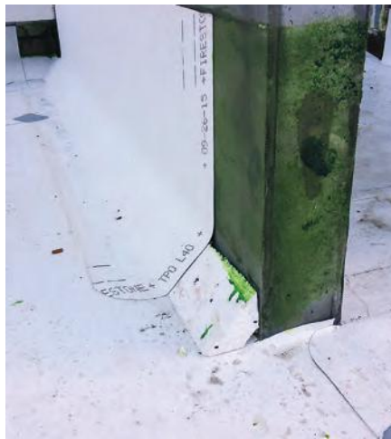
Wywinięcie membrany na ścianę
