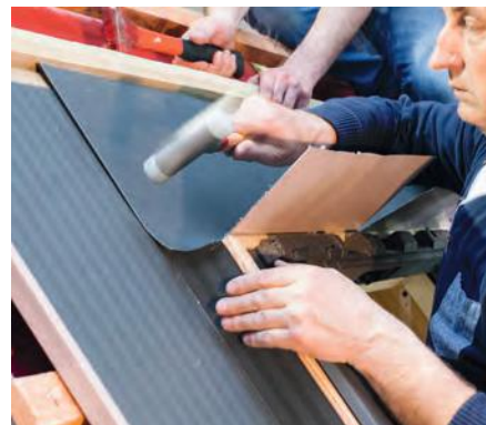
Montaż obróbki nad oknem dachowym
