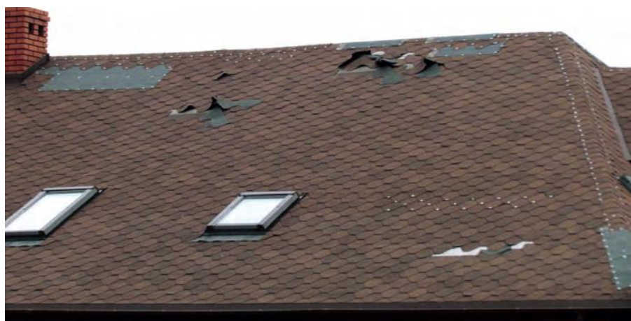
4. Gonty przybite tylko w górnej części listka
