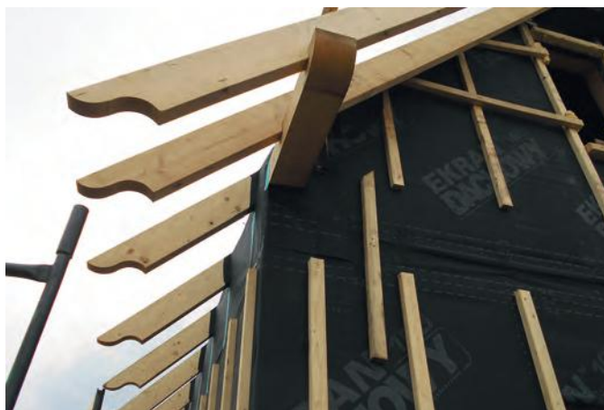
Fot. 2. Drewniany dom szkieletowy. Zamontowana po zewnętrznej stronie konstrukcji drewnianej MWK osłania ściany jako wiatroizolacja i podtrzymuje termoizolację ułożoną między belkami. W takich zastosowaniach powinno się używać mocnych MWK – ta ma gramaturę 165 g/m 2
