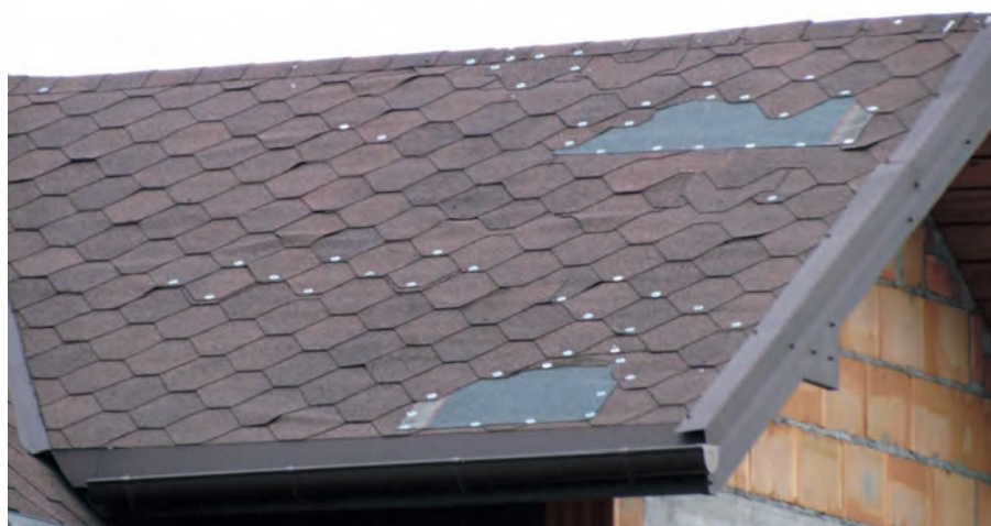
3. Gonty przybite tylko w górnej części listka
