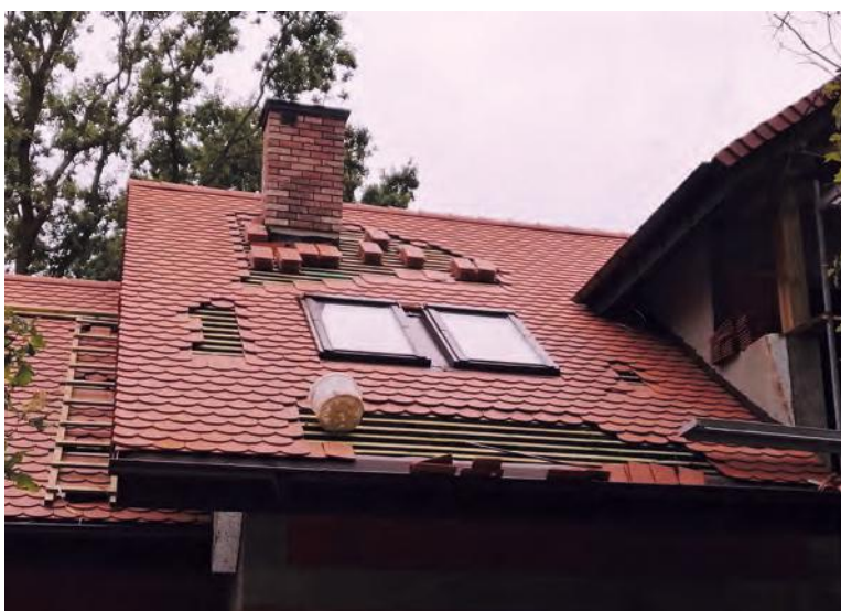
Każdy etap wykonania dachu powinien być skontrolowany zanim prace ulegną zakryciu
