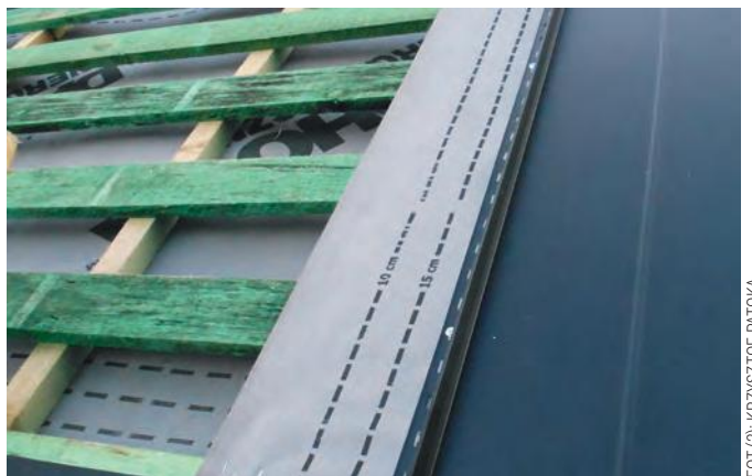
Fot. 4. Dach pokryty panelami zatraskowymi ułożonymi na półdeskowaniu. Między blachą a deskami jest specjalna MWK (o gramaturze 265 g/m 2 ) jako warstwa poślizgowa. Pod kontrłatami leży MWK w typowym zastosowaniu (o gramaturze 150 g/m 2 ). Włot do szczeliny jest pod pasem startowym
