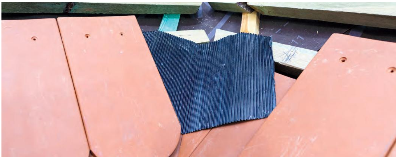
Początek budowania kosza z widoczną noką; zdjęcie ze szkoleń dekarzy
