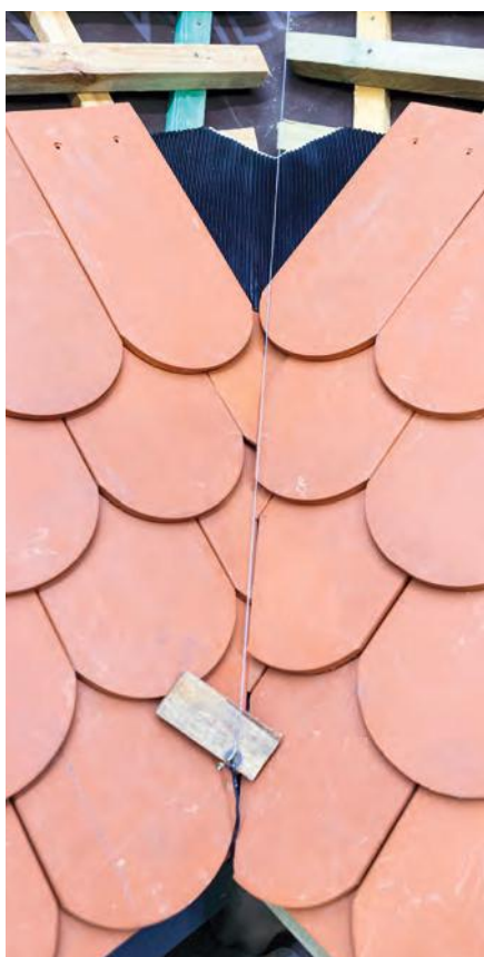
Kilka rzędów dachówek z widoczną noką i linią wyznaczającą środek; zdjęcie ze szkoleń dekarzy
