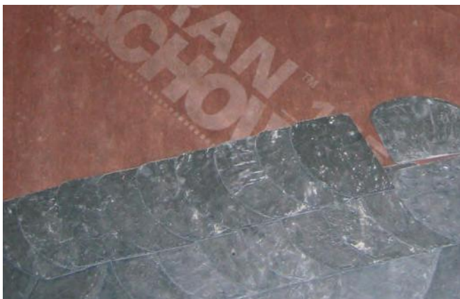
Fot. 3. Łupek kamienny uszczelniony jest WMK (o gramaturze 165 g/m 2 ), która jest ułożona na płycie OSB. Pod płytą jest przestrzeń wentylacyjna, ponieważ OSB jest materiałem paroizolacyjnym. Poddasze jest niemieszkalne – to wentylowany strych.
