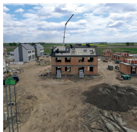
Dachy kryte dachówką betonową BMI Braas z systemem orynnowania cynkowo-tytanowego i oknami połaciowymi Velux
