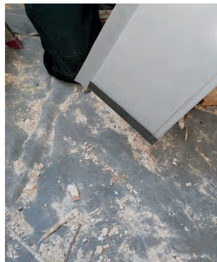
KROK 11. Dopasujemy elementy boczne kołnierza uszczelniającego do istniejącego pokrycia. Robimy falc do zapięcia dolnego elementu, nacinając boczną blachę kołnierza
