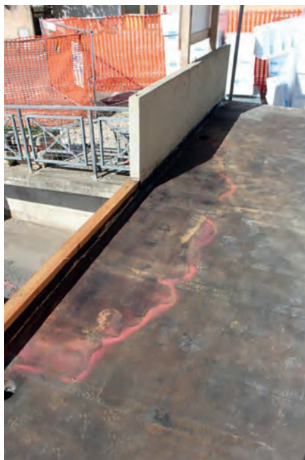
Wyrównywanie podłoża zaprawą bitumiczno-cementową
