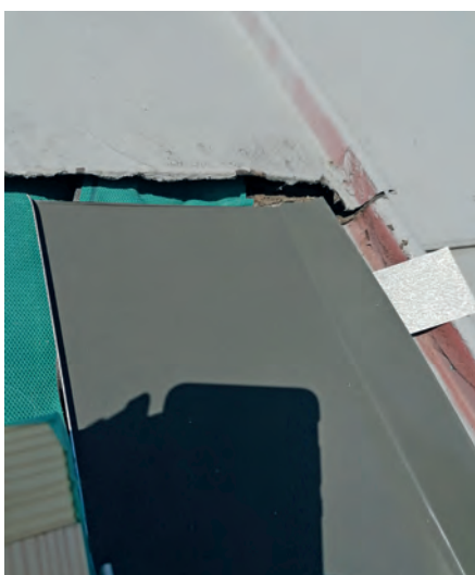
KROK 12. Wsuwamy obróbki pod pokrycie
