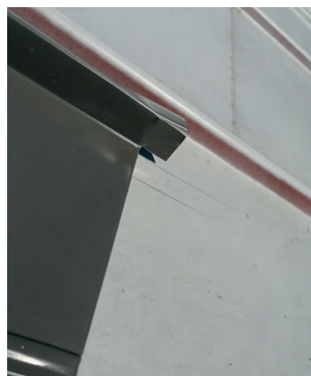
KROK 11. Dopasujemy elementy boczne kołnierza uszczelniającego do istniejącego pokrycia. Robimy falc do zapięcia dolnego elementu, nacinając boczną blachę kołnierza
