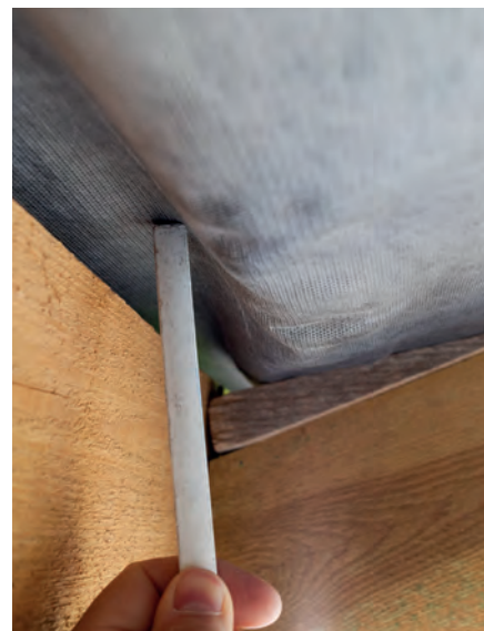
Folia wstępnego krycia ułożona niepoprawnie, co więcej na folii przed okapem utworzyło się wgłębienie i zator z odpadków drewna i gruzu
