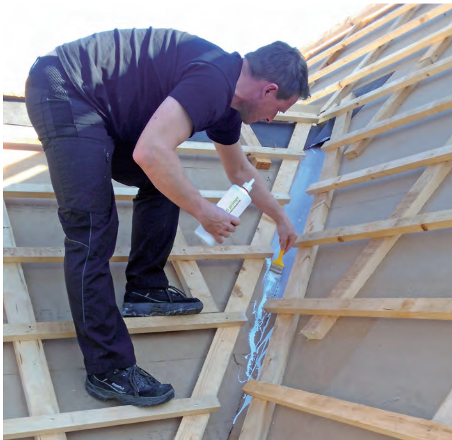
Prawidłowe uszczelnienie płyt nakrokwiowych STEICOuniversal w koszu za pomocą STEICOmultiprimer i STEICOmultiprimer F 150 mm
