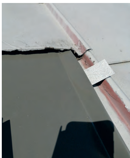
KROK 11. Dopasujemy elementy boczne kołnierza uszczelniającego do istniejącego pokrycia. Robimy falc do zapięcia dolnego elementu, nacinając boczną blachę kołnierza
