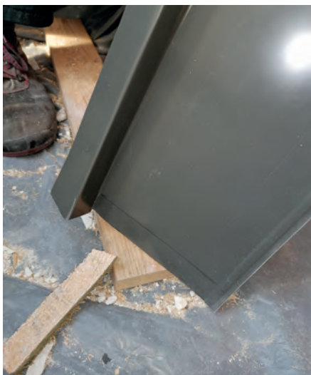
KROK 11. Dopasujemy elementy boczne kołnierza uszczelniającego do istniejącego pokrycia. Robimy falc do zapięcia dolnego elementu, nacinając boczną blachę kołnierza
