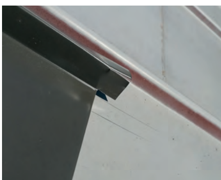
KROK 13. Montujemy obróbki do ramy okna i powtarzamy kroki z drugiej strony okna
