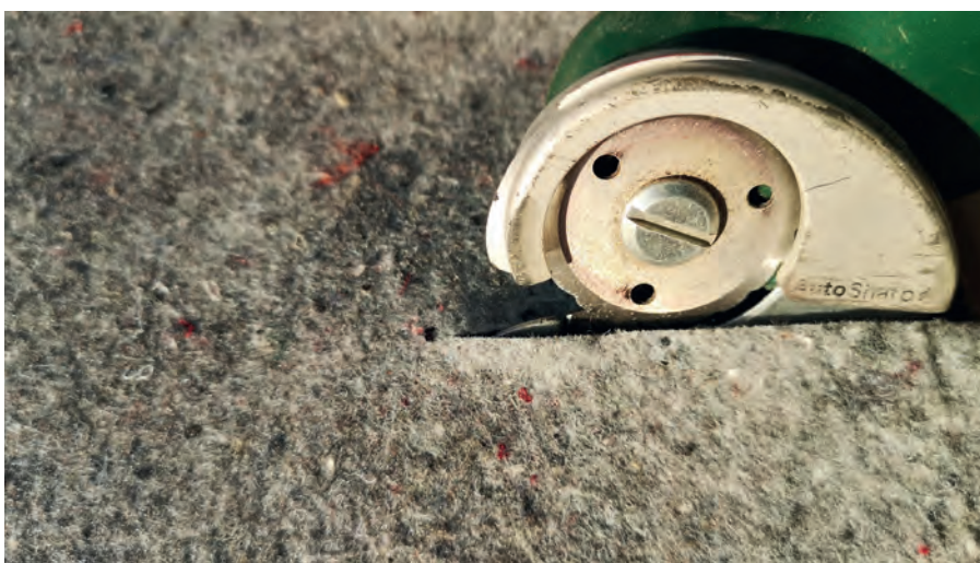
Fot. 3. Docinanie geowłókniny nożem krążkowym
