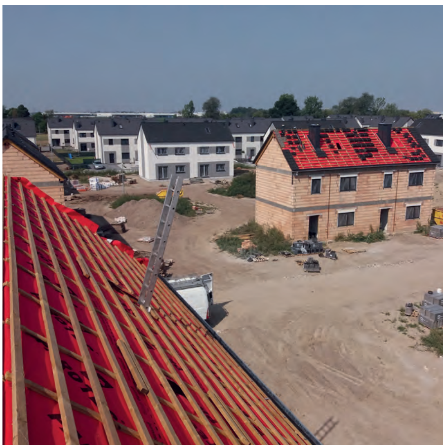
Dachy kryte dachówką betonową BMI Braas z systemem orynnowania cynkowo-tytanowego i oknami połaciowymi Velux
