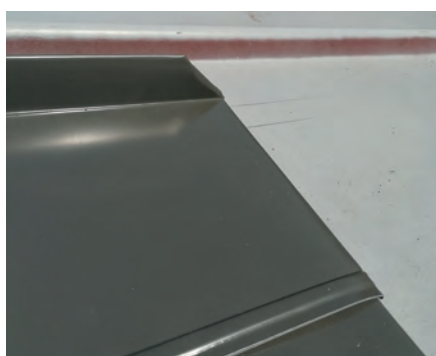
KROK 13. Montujemy obróbki do ramy okna i powtarzamy kroki z drugiej strony okna
