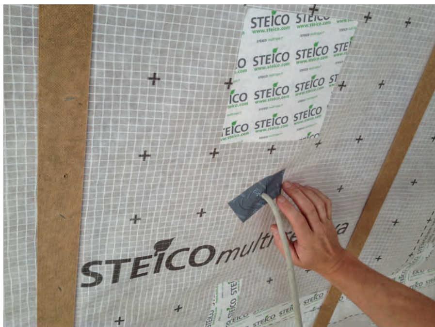
Uszczelnienie otworów instalacyjnych w membranie STEICOmultiprimer przy użyciu systemowych taśm STEICOmultiprimer
