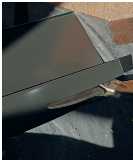
KROK 11. Dopasujemy elementy boczne kołnierza uszczelniającego do istniejącego pokrycia. Robimy falc do zapięcia dolnego elementu, nacinając boczną blachę kołnierza
