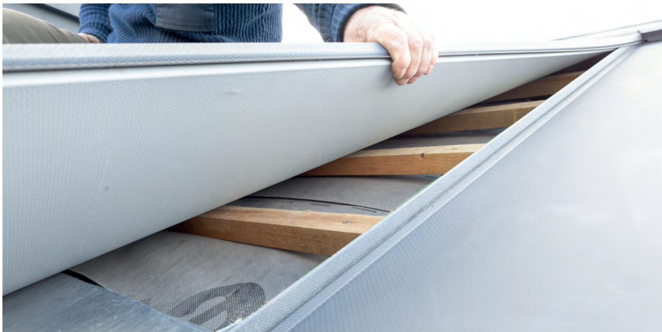
Nieprawidłowy montaż termoizolacji – upchnięta na siłę wełna mineralna prawie całkowicie zamknęła szczelinę wentylacyjną utworzoną pod łatami montażowymi
