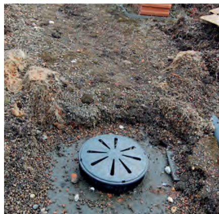
Wpust podciśnieniowy bez skrzynki kontrolnej
