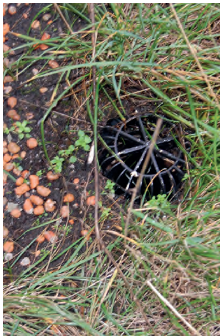
Brak skrzynki kontrolnej nad wpustem grawitacyjnym
