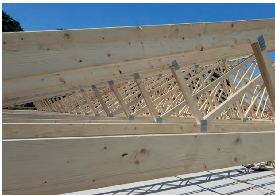
Dachy projektowane i produkowane w technologii B.PRO
