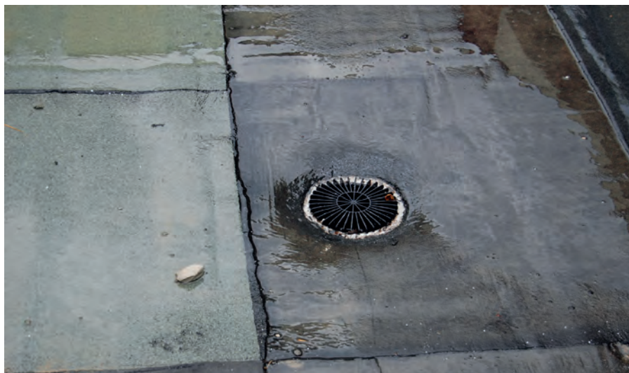
Właściwie wykonany wpust grawitacyjny
