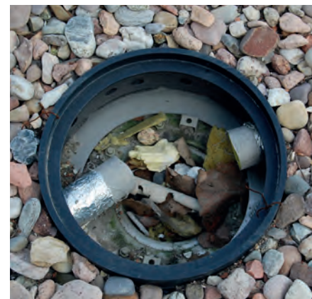
Wpust podciśnieniowy bez skrzynki kontrolnej
