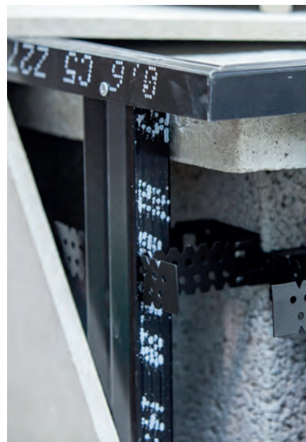
Na zdjęciach pokazano płytę włókno-cementową polskiej produkcji. Montaż takiej płyty w zasadzie niczym nie różni się od popularnej płyty OSB
