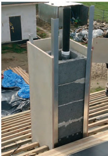
Na zdjęciach pokazano płytę włókno-cementową polskiej produkcji. Montaż takiej płyty w zasadzie niczym nie różni się od popularnej płyty OSB
