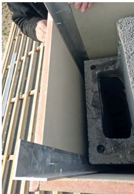
Na zdjęciach pokazano płytę włókno-cementową polskiej produkcji. Montaż takiej płyty w zasadzie niczym nie różni się od popularnej płyty OSB
