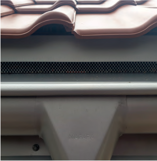
Fot. 4. Okap tego dachu został wykonany dokładnie według schematu z rys.1. Na końcu kontrłat zamocowana jest metalowa siatka, pod którą zamontowano pas do rynnowy. Rynna wisi na hakach doczołowych.
