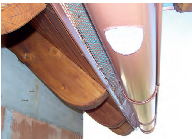
Fot. 5. Ten okap odzwierciedla schemat z rys.3. Pokryciem tego dachu jest dachówka betonowa. Rynna wisi na rynajzach zamocowanych nad łątą okapową do kontrłat. Pod dachówką zamocowano grzebień antywróblówki
