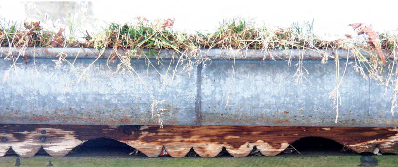
Fot. 1. Okap dachu zbudowanego ponad 100 lat temu (okolice Olsztynka) z wlotem do szczeliny wentylacyjnej na końcu kontrłat osłoniętym ozdobną listwą – tak jak na rys. 3
