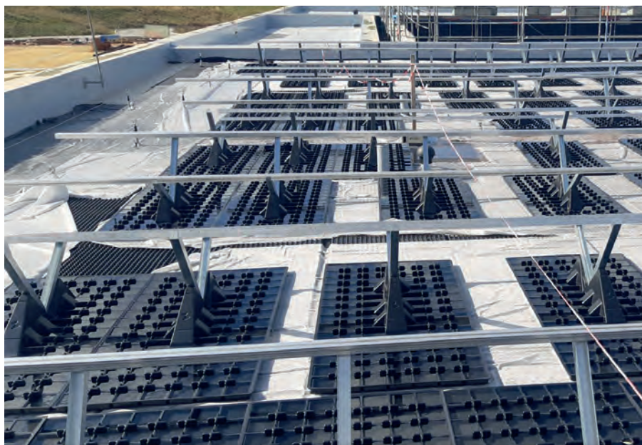
Montaż stojaków pod ogniwa fotowoltaiczne, który nie wymaga ingerencji w warstwę izolacyjną dachu
