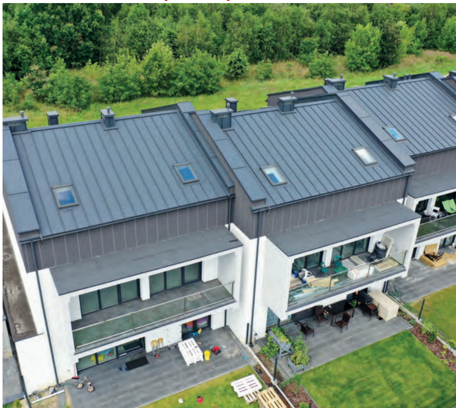
Dach kryty blachą na rąbek stojący Ruukki Classic
