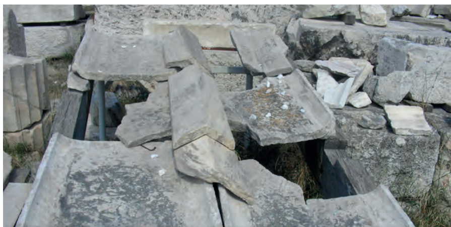
Fot. 2. Zachowane dachówki marmurowe, pokazywane w ateńskim muzeum pod Olimpem. Na wierzchu leżą wykute w kamieniu nakładki, które później w wersji ceramicznej stały się mnichami
