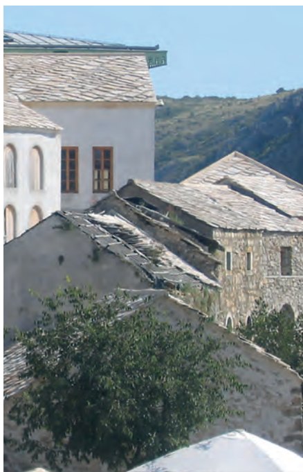
Fot. 4. Kamienne dachy w Mostarze. W dolnym prawym rogu widać dach w trakcie remontu, w trakcie którego jest pokrywany kamieniami układanymi na łątach
