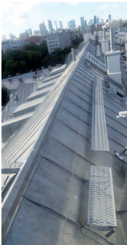
Dach kryty blachą cynkowo-tytanową firmy Rheinzink, łączoną na podwójny rąbek stojący
