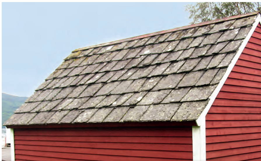
Fot. 1. Często spotykane w Norwegii pokrycia kamienne z miejscowego łupka. Bardzo oryginalna metoda polegała na starannym doborze wielkości kamieni. Na dole większe są uszczelniane wąskimi paskami, a na górze – na odwrót
