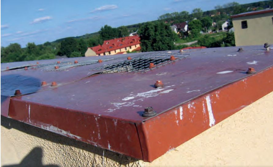
Fot. 1. Przykład trwałości połączeń blach na czteroletnim kominie. Obficie wkręcone blisko siebie farmery niczego nie gwarantują, ponieważ są stale poruszane prostopadle do osi wkręcenia. To dzieje się pod wpływem zmian temperatury. Długość wydłużenia nie ma tu znaczenia, lecz ilość dziennych cykli tych ruchów, bo farmer jest często wilgotny
