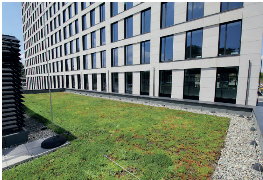
Opaski żwirowe na dachu w uprawie ekstensywnej
