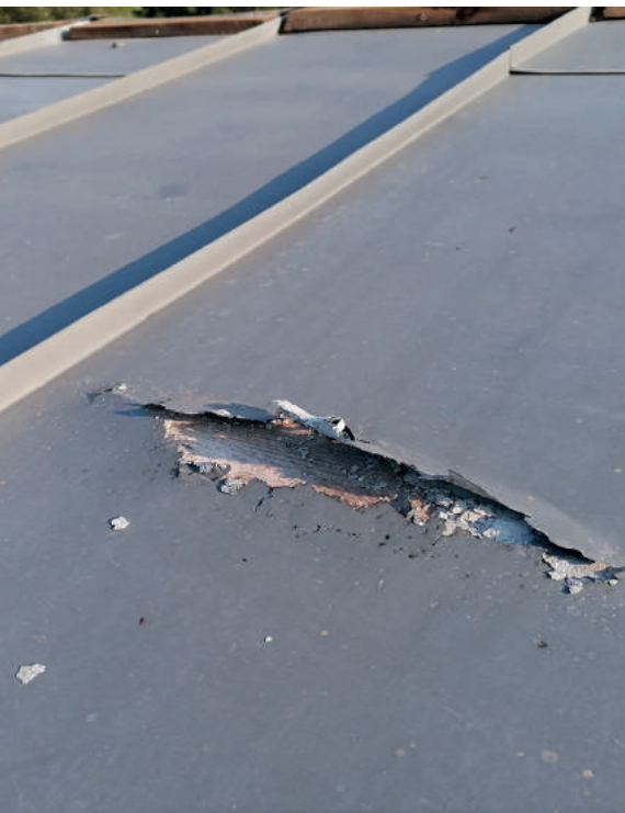
Fot. 2. Na opisywanym dachu, prawie wszystkie uszkodzenia blachy przez gorącą wodę były w miejscach, w których stykała się ona z deskami poszycia. Jest to oczywiste, ponieważ w zawilgoconych deskach może być zgromadzona woda w ilościach umożliwiającą powstanie tego efektu, a oprócz tego deski zeszkobują węglan cynku zabezpieczający blachę
