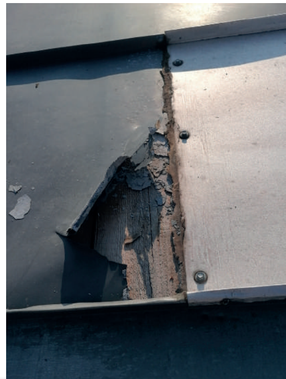
Fot. 2. Na opisywanym dachu, prawie wszystkie uszkodzenia blachy przez gorącą wodę były w miejscach, w których stykała się ona z deskami poszycia. Jest to oczywiste, ponieważ w zawilgoconych deskach może być zgromadzona woda w ilościach umożliwiającą powstanie tego efektu, a oprócz tego deski zeszkobują węglan cynku zabezpieczający blachę
