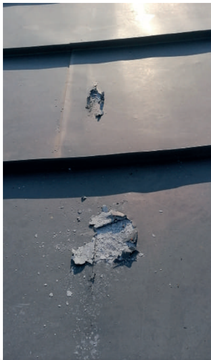
Fot. 2. Na opisywanym dachu, prawie wszystkie uszkodzenia blachy przez gorącą wodę były w miejscach, w których stykała się ona z deskami poszycia. Jest to oczywiste, ponieważ w zawilgoconych deskach może być zgromadzona woda w ilościach umożliwiającą powstanie tego efektu, a oprócz tego deski zeszkobują węglan cynku zabezpieczający blachę
