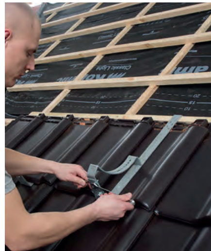
Montaż wsporników pod ławę kominiarską
