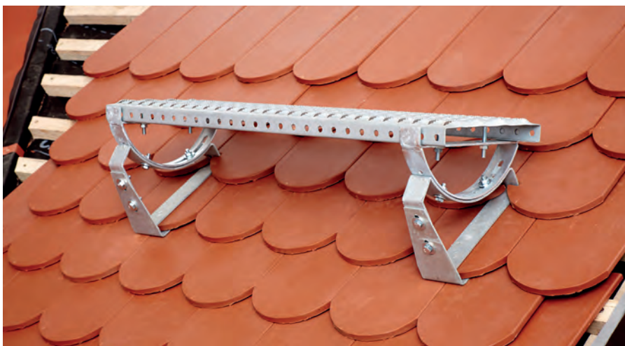
Zamontowana ława kominiarska
