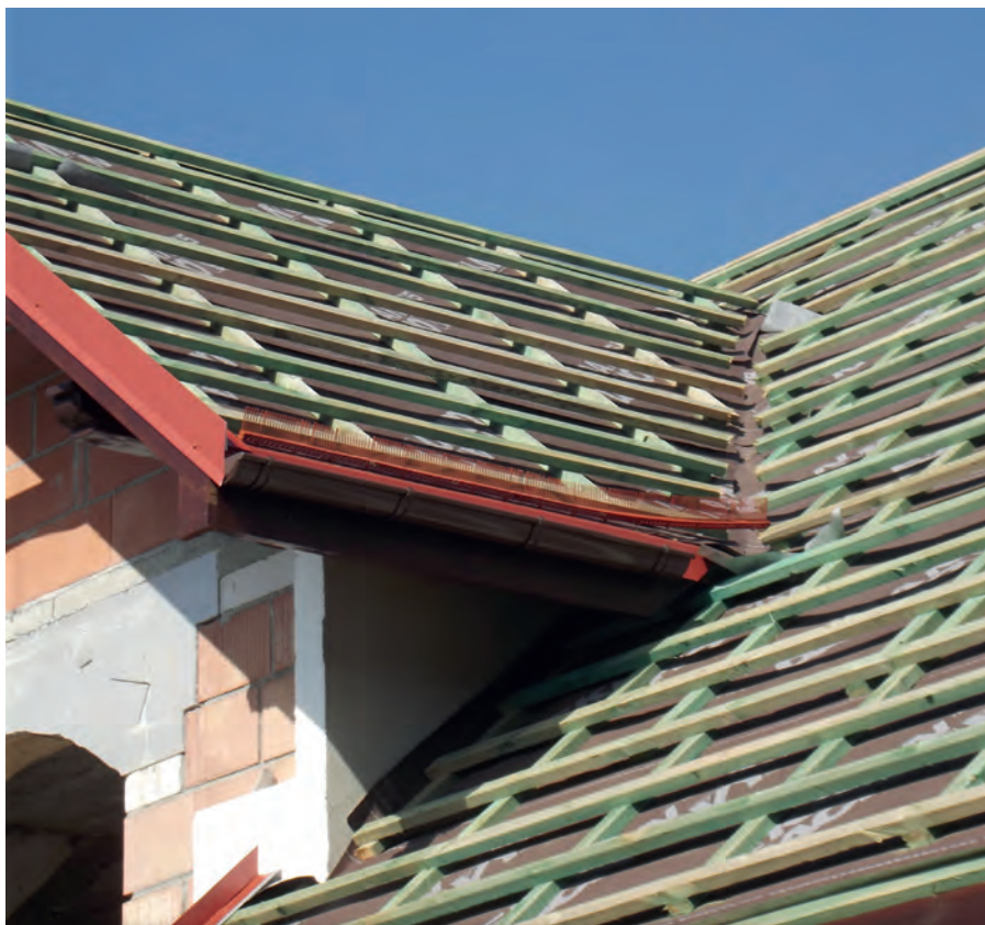
Fot. 2. Typowo wykonany dach pochyły z warstwą uszczelniającą pokrycie zasadnicze wykonaną z MWK. Skrót MWK oznacza według [2] wysokoparoprzepuszczalną membranę wstępnego krycia o określonych własnościach dyfuzyjnych
