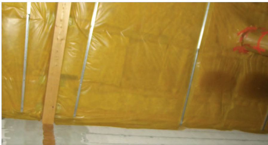
Fot. 3. Dach dużej hali sportowej. Paroizolacja z PP jest podziurawiona spinkami (zszywkami) i niezaklejona na zakładach. Przy przewodzie wentylacyjnym widać ślady zacieków ze skroplin. To miejsce nie jest przypadkowe. Przy rurze było i jest (mimo próby uszczelnienia) najwięcej szpar i najwięcej ruchów powietrza
