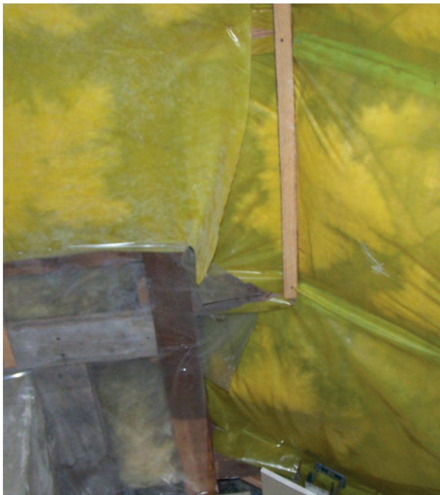
Fot. 2. Typowe ułożenie paroizolacji z folii PP (polipropylenowej). Same dziury i szpary na wszelkich połączeniach. Z tego powodu obok miejsc przenikania powietrza powstały widoczne zmiany zabarwienia wełny mineralnej. W tych miejscach para wodna i jej skropliny zmieniły kolor wełny
